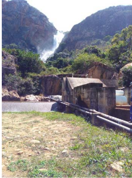
Figura 7 – Captação Livramento de Nossa Senhora; EMBASA 2019.
