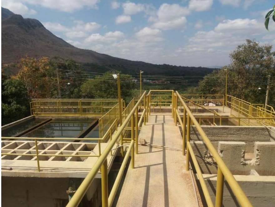
Figura 5 - ETA de Livramento de Nossa Senhora; EMBASA 2019.
